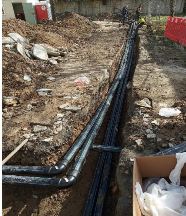
Distribución das tuberías no exterior
